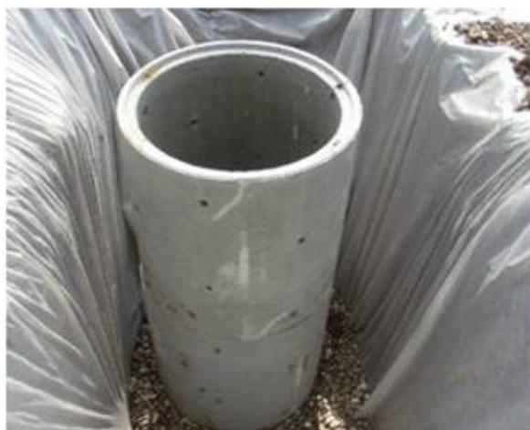
Le puits d'infiltration remplace le principe du puits perdu, et permet de stocker temporairement l'eau de pluie, puis les évacue par infiltration dans le sol.
